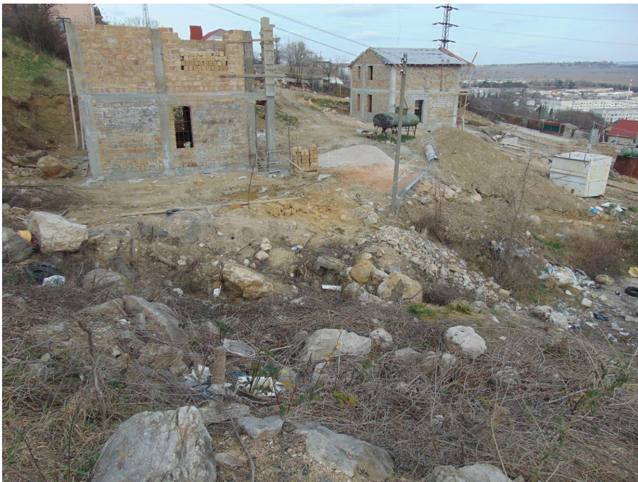
Фото № 2 Строительство ИЖС в средней части у левого борта Балаклавского оползня № 126 (67-1110-0002)
