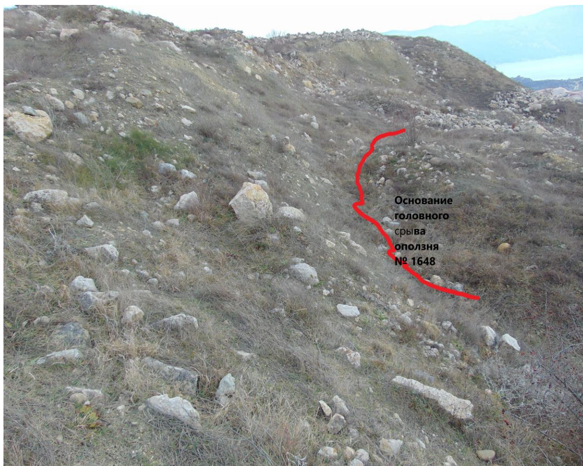
Фото № 3. Основание головного срыва «Василевского» (№ 1648) оползня (67-1110-0003)
