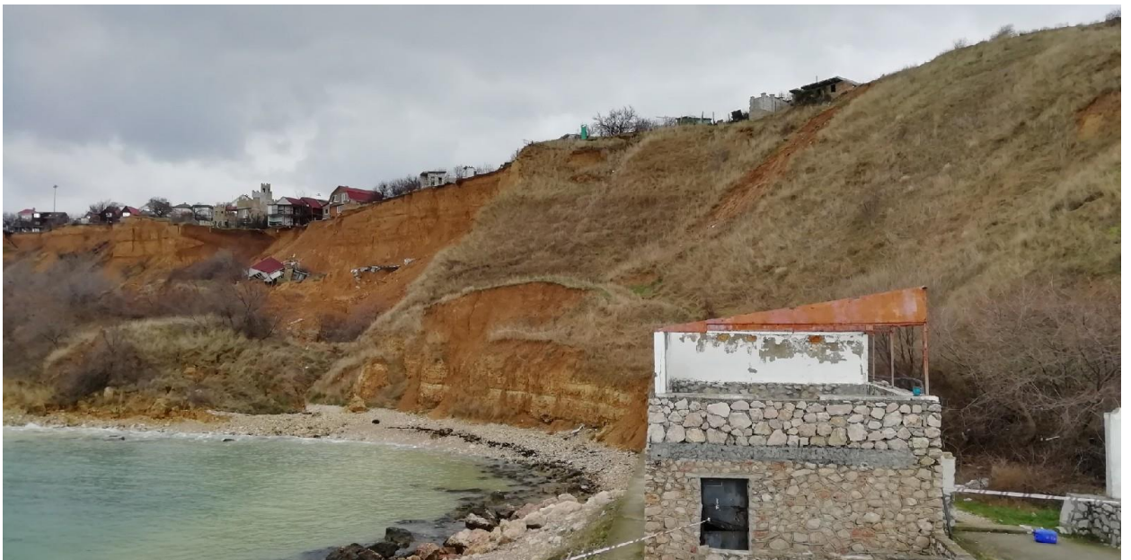
Фото № 14. Общий вид склона, испытывающего деформации оползневого характера (67-1110-0009)
