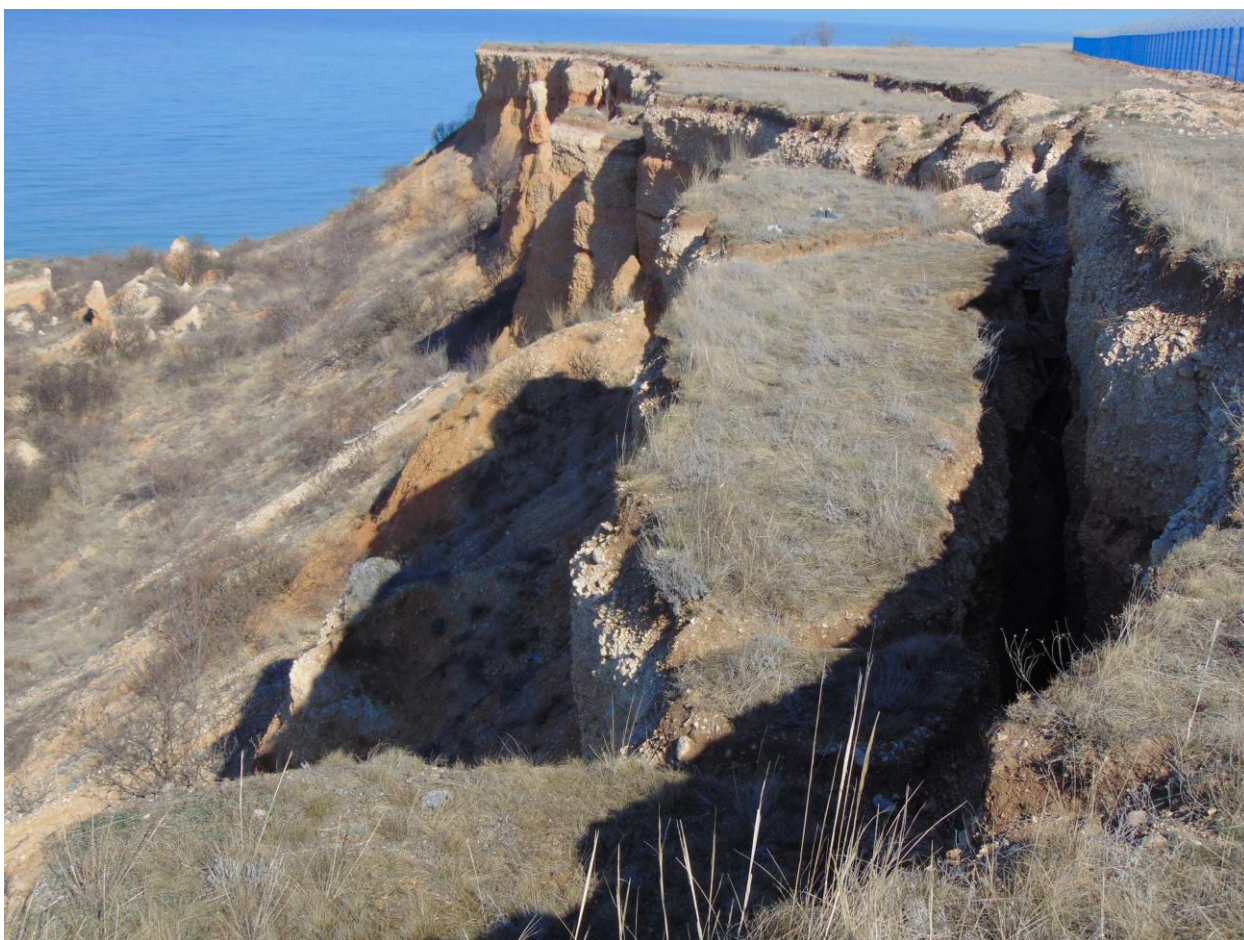
Фото № 8. Закол блока вдоль бровки головного срыва «Любимовского большого» оползня. (67-1110-0006)
